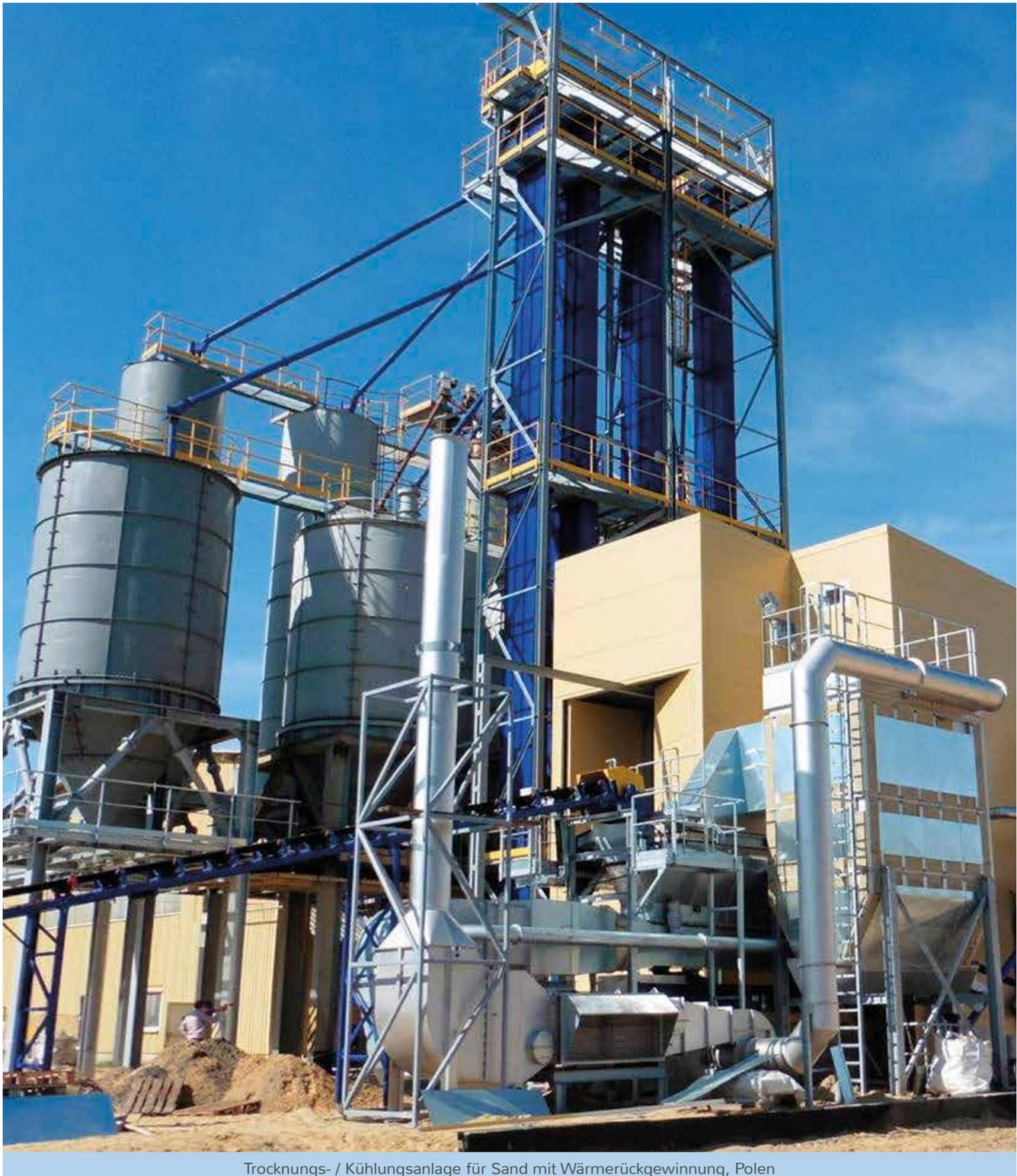
Trocknungs- / Kühlungsanlage für Sand mit Wärmerückgewinnung, Polen
