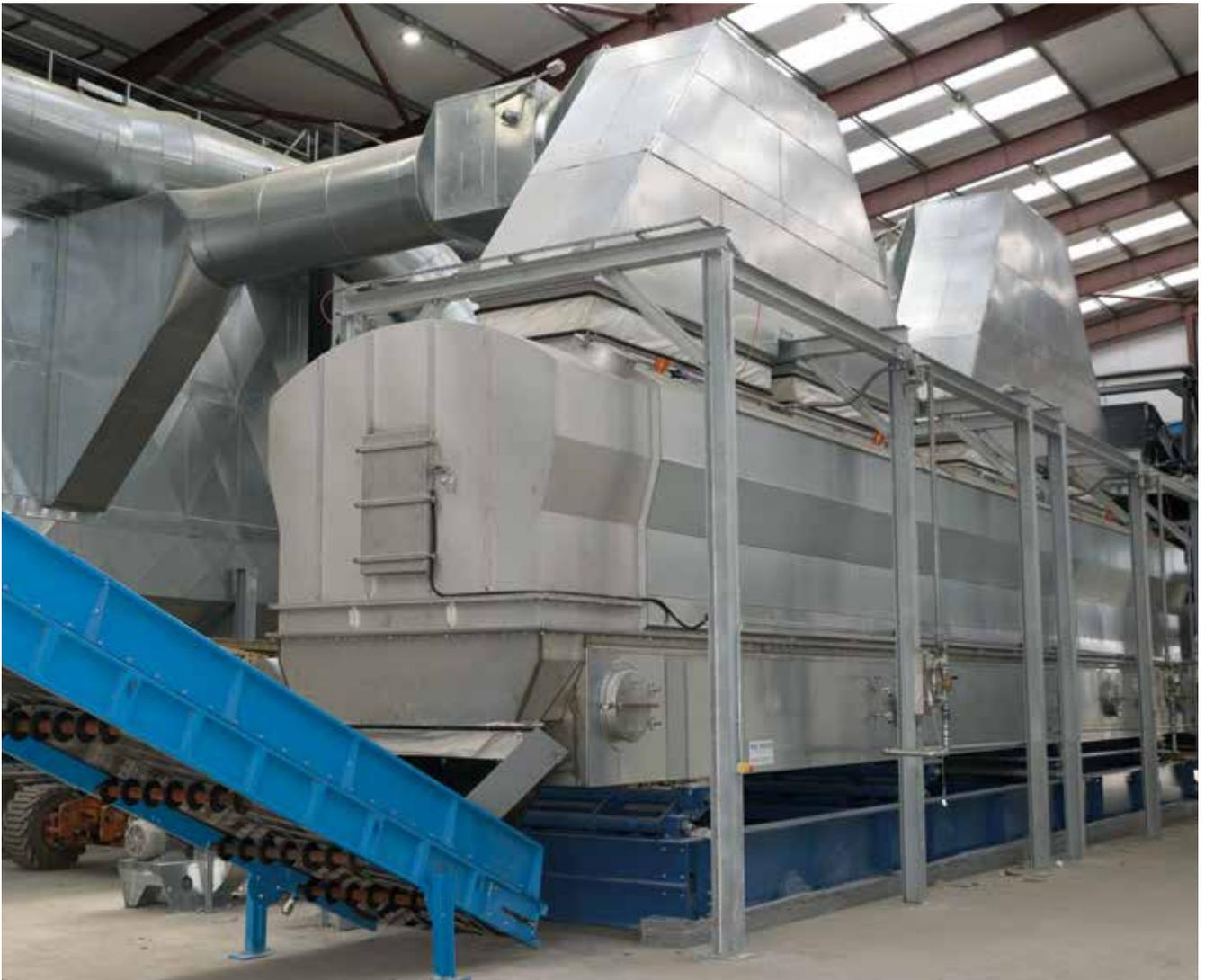
RDF/SRF Trocknungs- / Kühlungsanlage RiverRidgeRecycling
