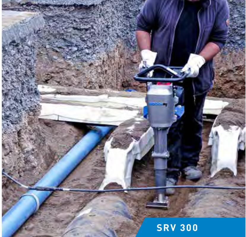
Gute Verdichtungsergebnisse, hoher Bedienkomfort und vor allem eine robuste und langlebige Konstruktion: das sind wesentliche Anforderungen, die Vibrationsstampfer erfüllen müssen.
