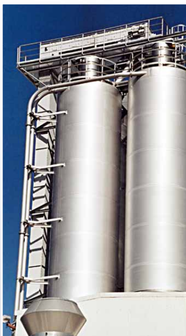
Stabile geschlossene Blechkonstruktion
