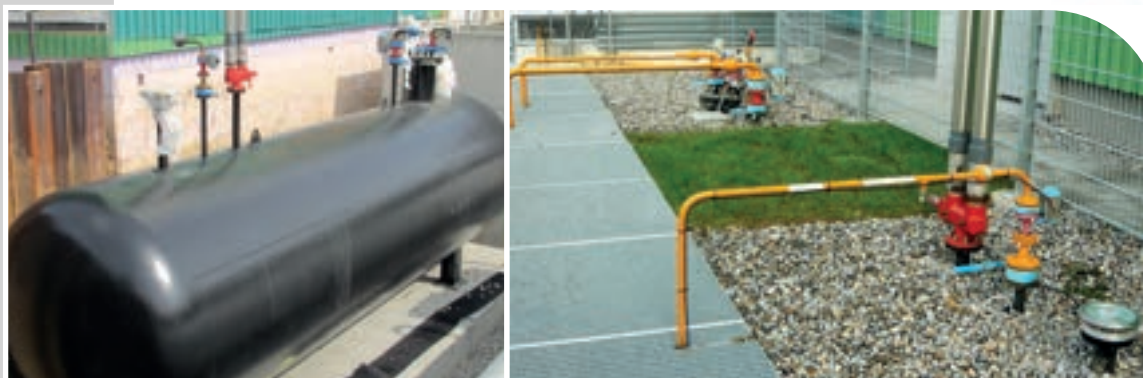
Serbatoio sotto suolo in box di cemento armato per Gas Refrigeranti infiammabili/non infiammabili. StorageTank under-ground in concrete box for Refrigerant Gas (flammable or not flammable).
