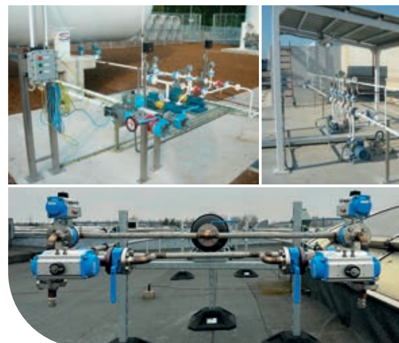
Gruppi pompe gas refrigerante alla produzione (bassa pressione). Pump groups for refrigerant gas (low pressure)
