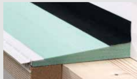
Keil mit EPDM-Dichtfolie und Tropfkantprofil
