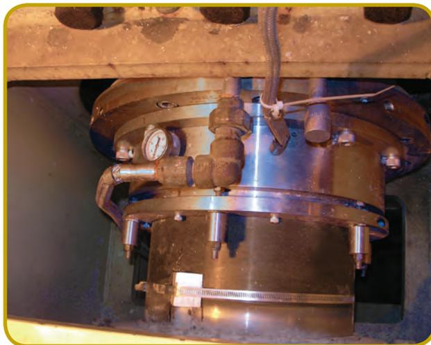
**MECO-DICHTUNG ZUR EINDÄMMUNG EINES GIFTIGEN GASES IN EINEM REAKTOR/TROCKNER**
