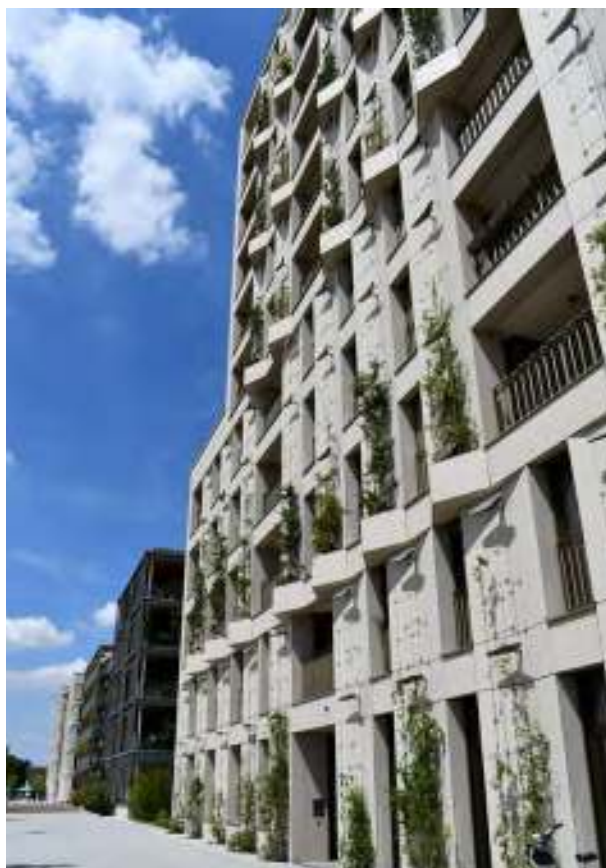
Abb. 13: Wandgebundene Fassadenbegrünung in Regalbauweise (horizontal). Quelle: BuGG
