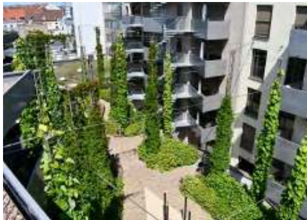
Abb. 11: Bodengebundene Fassadenbegrünung, hier mit Kletterhilfen. Quelle: BuGG
