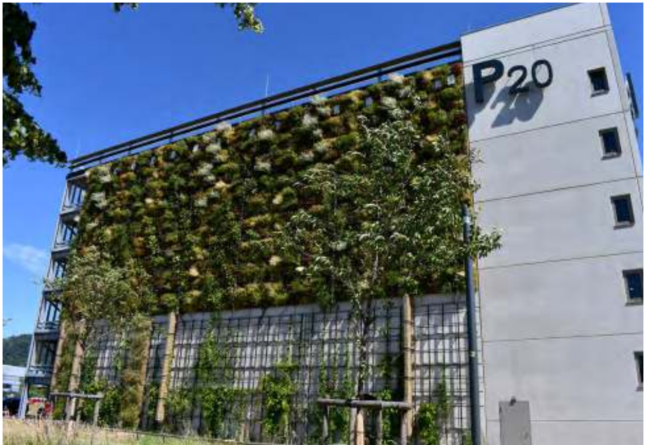
Abb. 57: In Deutschland wurden in 2024 etwa 109.600 m 2 bodengebundene Fassadenbegrünungen mit Kletterhilfen (unten im Bild) und etwa 27.500 m 2 wandgebundene Fassadenbegrünungen (oben im Bild) umgesetzt. Quelle: BuGG
