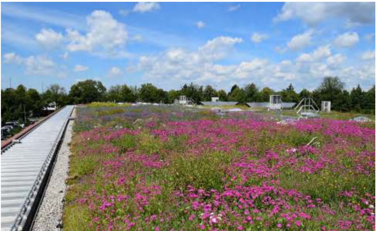
Abb. 10: Extensive Dachbegrünung, hier als Biodiversitätsgründach. Quelle: BuGG
