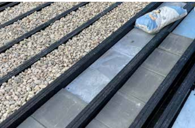
Systemlösung: Kombination aus Windsog- und Brandschutz-Anforderungen
