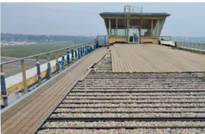
Systemlösung: Kombination aus Windsog- und Brandschutz-Anforderungen
