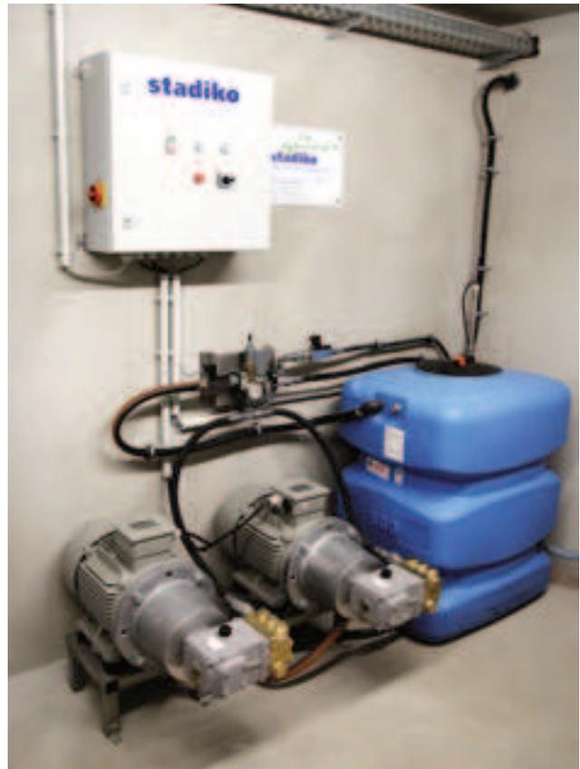
Doppelstufenanlage für zwei Anwender
