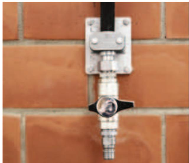
Der Bewegungsschlauch wird an optimal positionierten Zapfstellen angekoppelt. So kann effektiv und außerdem kostensparend gereinigt werden, da lange Rüstzeiten entfallen.
