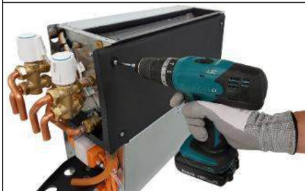
Abb. 56: Hauptkondensatwanne (Wandausführung) demontieren
