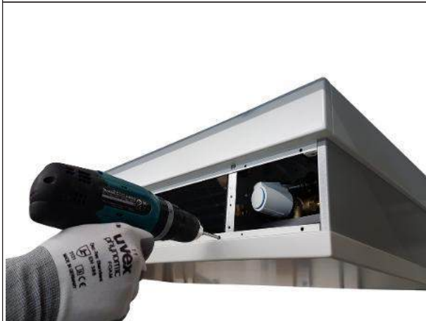
Abb. 9: Verkleidung mit Schrauben befestigen
