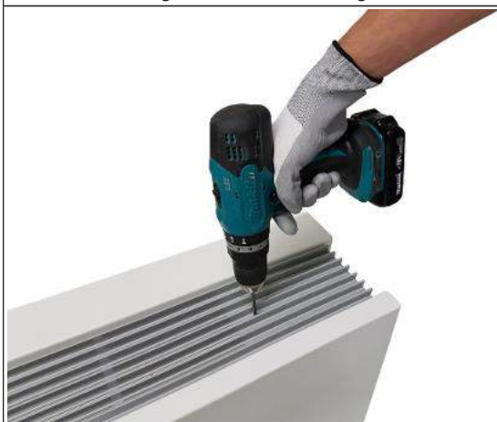
Abb. 10: Luftaustrittsgitter verschrauben.
