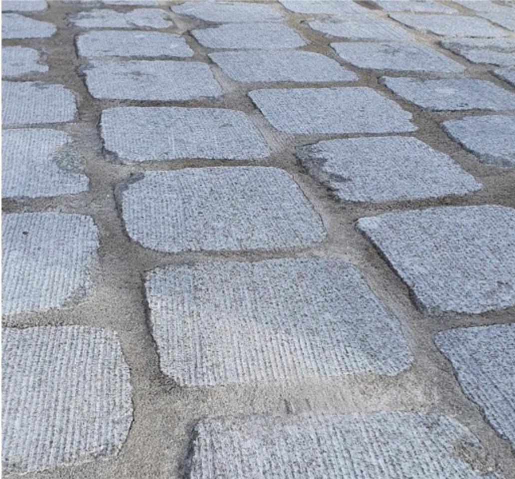
Nach dem Bearbeiten mit der BEF 400RC mit Trennscheiben auf dem Rotor: ein barrierefreier Weg zum Beispiel für Rollstühle, Rollatoren, Fahrräder etc.
