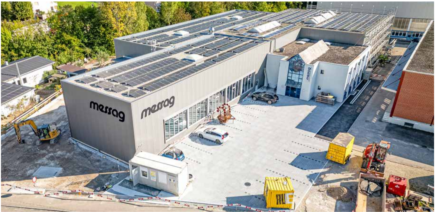
Wie ein «S» schmiegt sich die neue Halle an den bestehenden Bau der Messag AG. Beide Immobilien sind dreifach-verglast und top isoliert.
