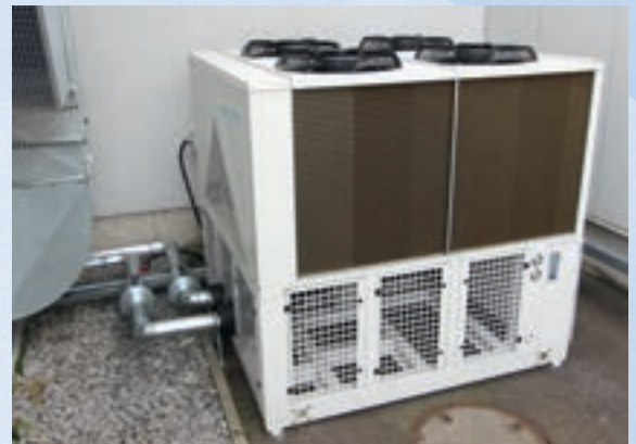
Antriebswellenhersteller, 200 kW, R410A, mit Freikühlung
