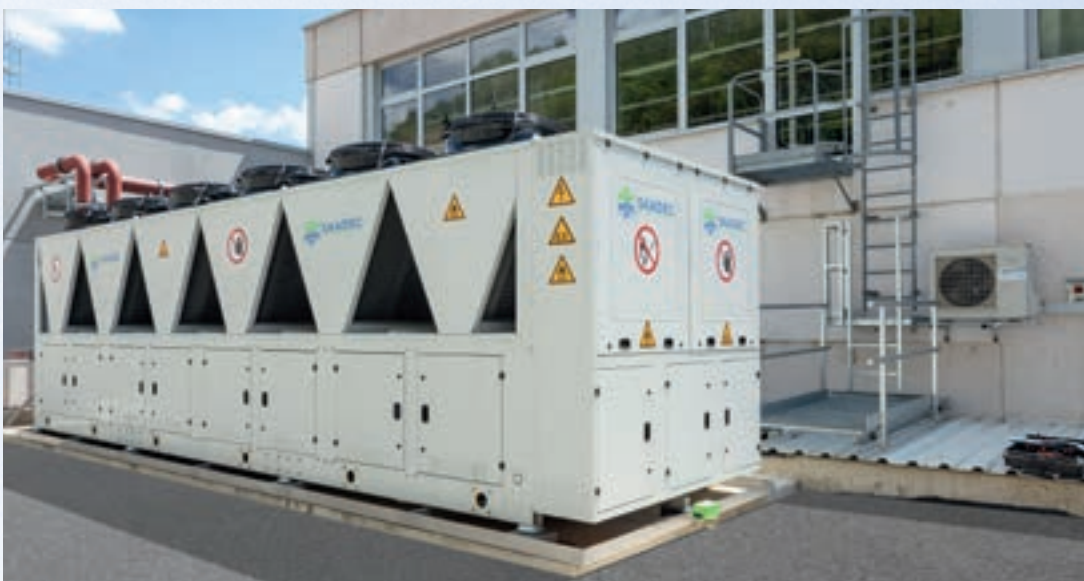
Ventilatoren- und Motorenhersteller, 407 kW, R290
