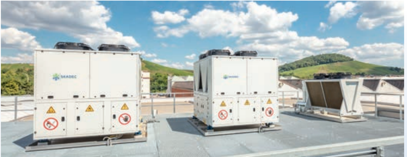
Automobilzulieferer, Redundant 2x103 kW, R290
