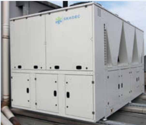
Bürogebäude, 250 kW, R410A
