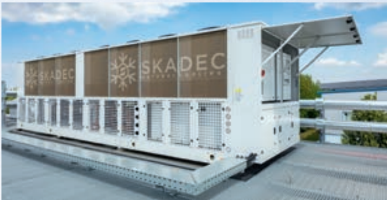
Leiterplattenhersteller, 910 kW, R410A, mit Freikühlung
