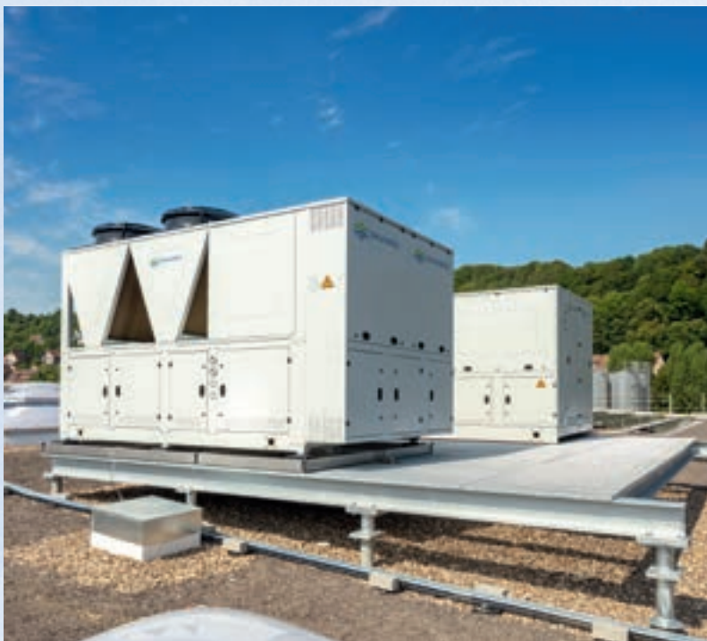
Supermarkt, 79 kW, R290, Kaltwassersatz und 158 kW, R290, Wärmepumpe
