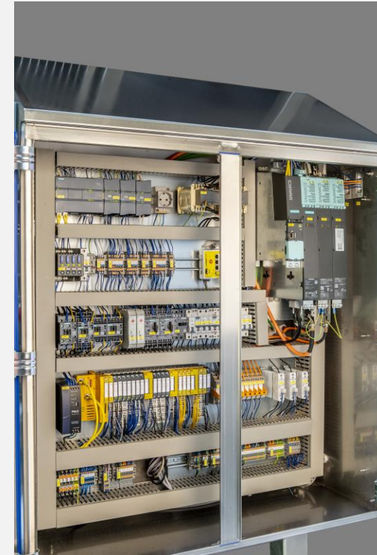
Siemens Simatic SPS Steuerung und Komponenten.
