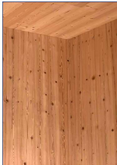
Brettsperrholz-Wände mit Exklusiv-Oberfläche in Altholz
