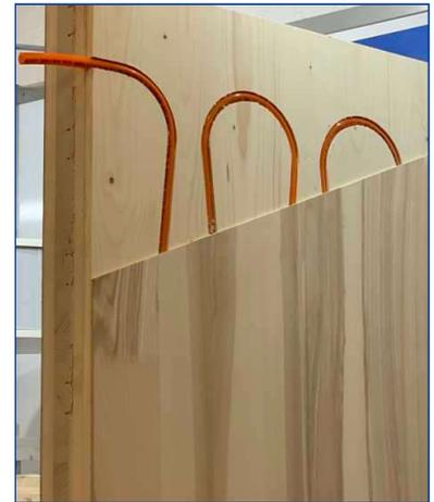
Wasserführende Heizung / Kühlung in BSP-Deckenelement mit Exklusiv-Obfl.
