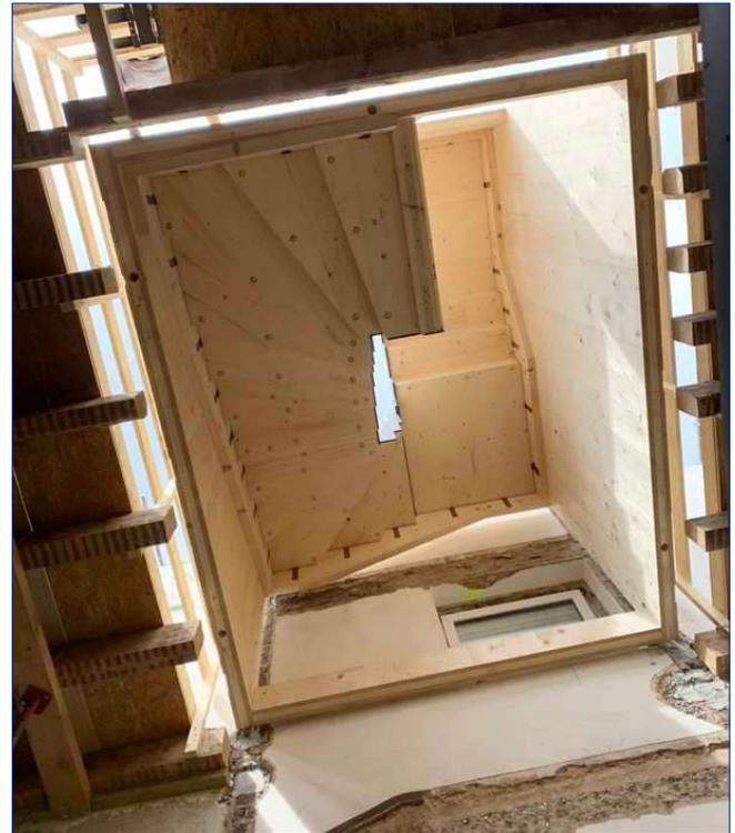
Bild oben: Modul wird in Bestand herabgesenkt
