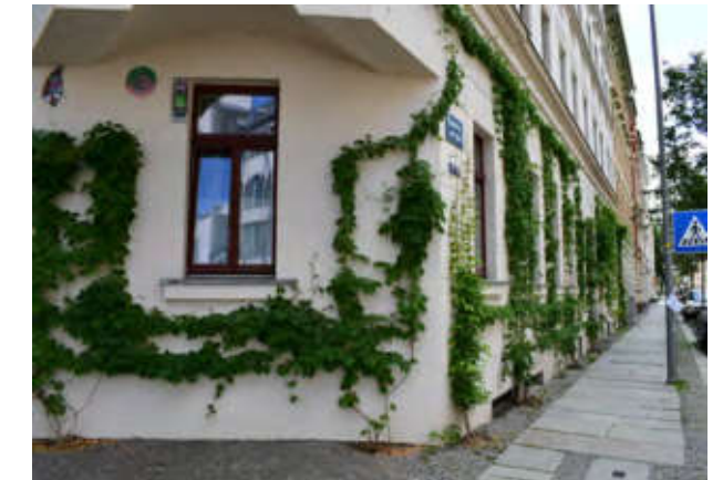
Abb. 11: Bodengebundene Fassadenbegrünung, hier mit Kletterhilfen. Quelle: BuGG
