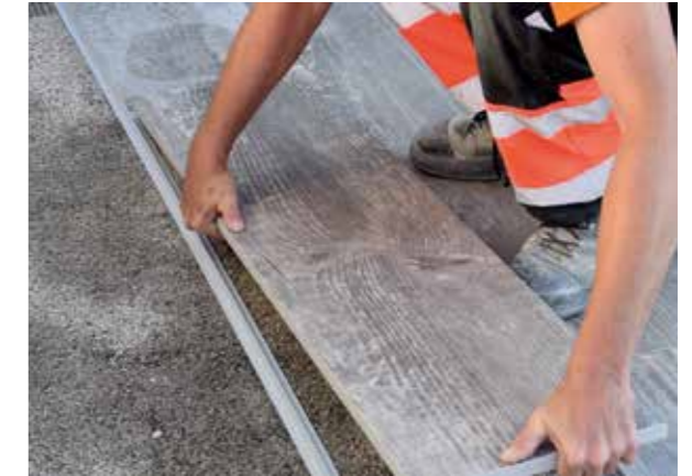
Kein Wippen dank durchgehende Auflage der Plattenkante.
