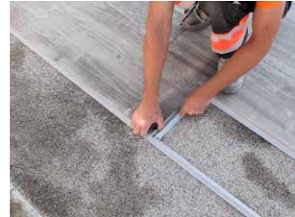
Die Querprofile lassen sich nachträglich unter die Platte schieben.
