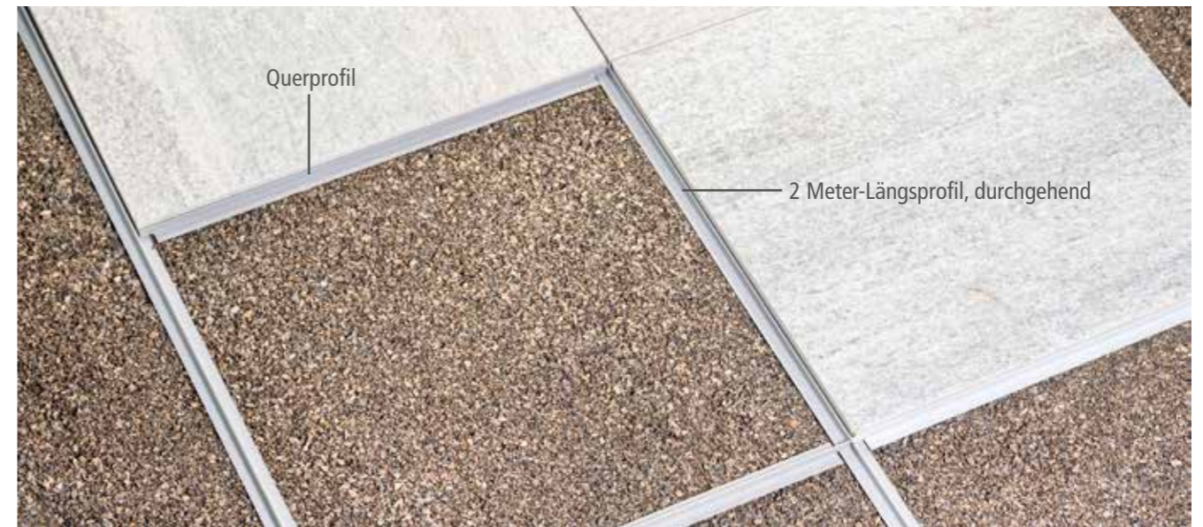
Die Querprofile lassen sich nachträglich unter die Platte schieben.
