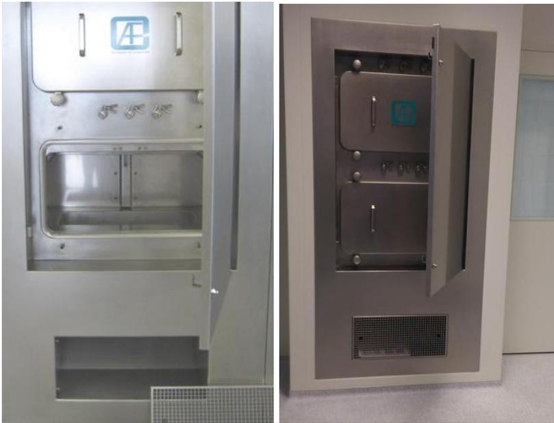
AFC Wall Filter Box: in der Wand eingebaute Filterbox
