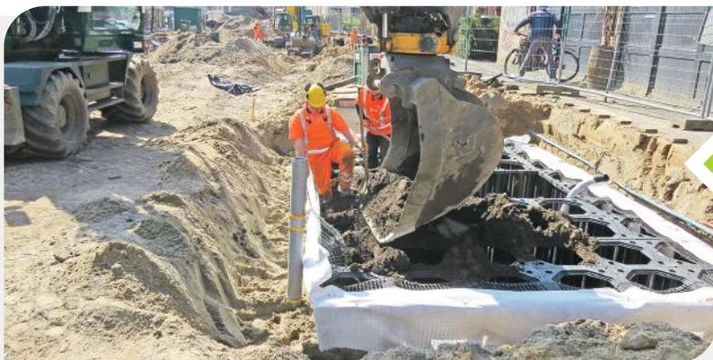
Das Treeparker® System ist sehr einfach zu installieren. Durch die einfache Konstruktion spart es dem Bauunternehmer viel Zeit. "Das Auffüllen mit Erde ist oft eine zeitraubende Tätigkeit, beim Treeparker geht's viel schneller. Aber die meiste Zeit konnten wir sparen, weil bestehende Kabel in das System integriert werden konnten. Das war ja Super"
