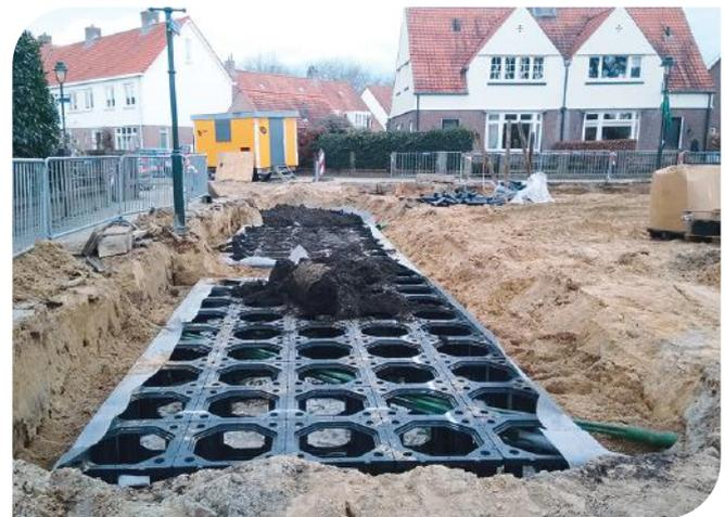
Nach Installation aller Einheiten und Integration der Kabel und Leitungen wird das System von einer vertikalen Wand umschlossen. Diese Wand kann sowohl wasserdurchlässig als auch wurzeldicht ausgeführt werden.
