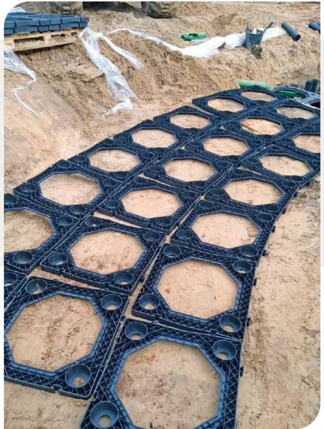
Die Rahmen (frames) werden gemäß Layoutzeichnung platziert. Die Einheiten können mit maximal 75 mm Abstand installiert werden, wodurch auch Kurven und abweichende Formate möglich werden. Gesamtgröße max. 675 x 675 mm.
