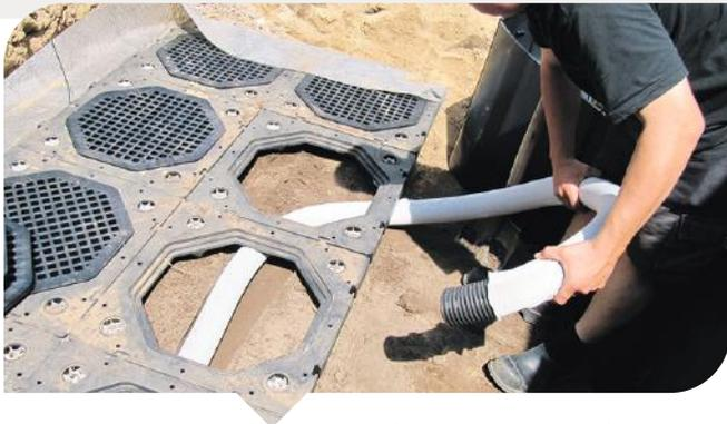
Das System wird nicht vollständig gefüllt; eine variable Luftschicht ist notwendig, um Schäden durch Wurzelwachstum zu vermeiden. Die Luftschicht wird mit einem Belüftungs-/Bewässerungssystem versehen, das für die Zuleitung von Sauerstoff und Wasser notwendig ist.
