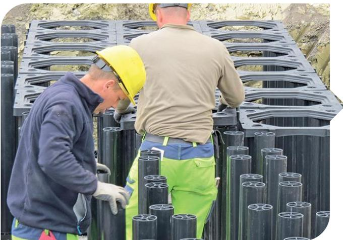
Nach Platzierung der Rahmen gemäß Zeichnung werden die Pfähle (posts) eingesetzt und der Abdeckrahmen (frames) installiert. Die Pfähle sind in jeder Höhe lieferbar. Sogar während der Installation kann die Höhe noch an eventuelle unerwartete Gegebenheiten angepasst werden.
