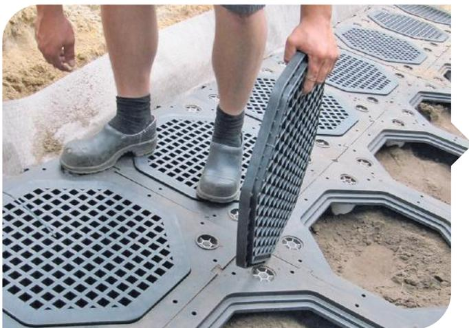
Nachdem alles installiert ist, kann das System verschlossen werden. Das System eignet sich auch für den Einsatz unter wasserdurchlässiger Fahrbahndecke, denn das Regenwasser infiltriert durch die Abdeckungen (decks) bis in das Baumsubstrat.
