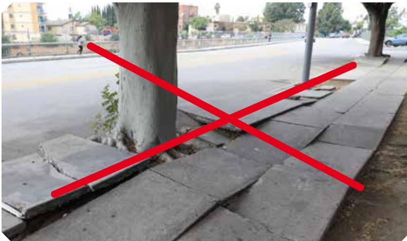
Wenn Bäume wachsen, wächst auch ihr Wurzelvolumen. Infolgedessen dehnen die Baumwurzeln den Boden aus, was zu einer Anhebung des Pflasters führt. Auch in Baums substrat (FFL 2) drücken die Wurzeln schließlich die Steine auseinander. In Baumrigole System bewirken die Baumwurzeln ebenfalls eine Ausdehnung des Bodens. Der Boden kann sich jedoch in der Luftschicht unter den Belägen ausdehnen, was eine Beschädigung des Pflasters verhindert.
