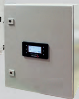
TR-Basic Regelung zur wirtschaftlichen Ansteuerung von Kastenklimategeräten
