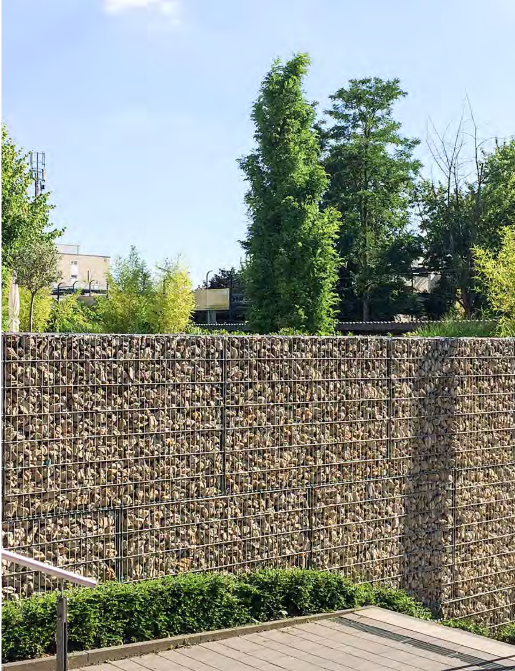
RAWE-STEINKORB, FÜLLUNG DIETFURTER DOLOMIT®, Körnung 63/100 mm
