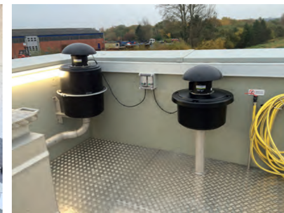
Rohrendfilter auf dem Dach installiert
