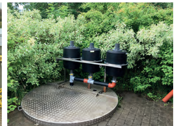
Dreifachfilter am Pumpwerk
