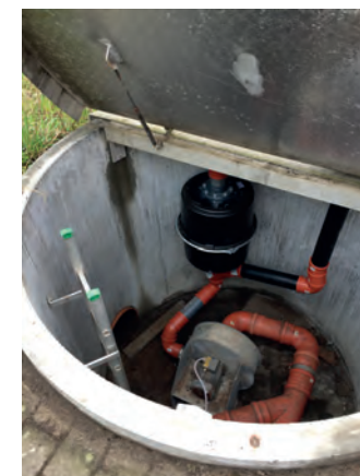
Filter platzsparend im Bauwerk eingebaut
