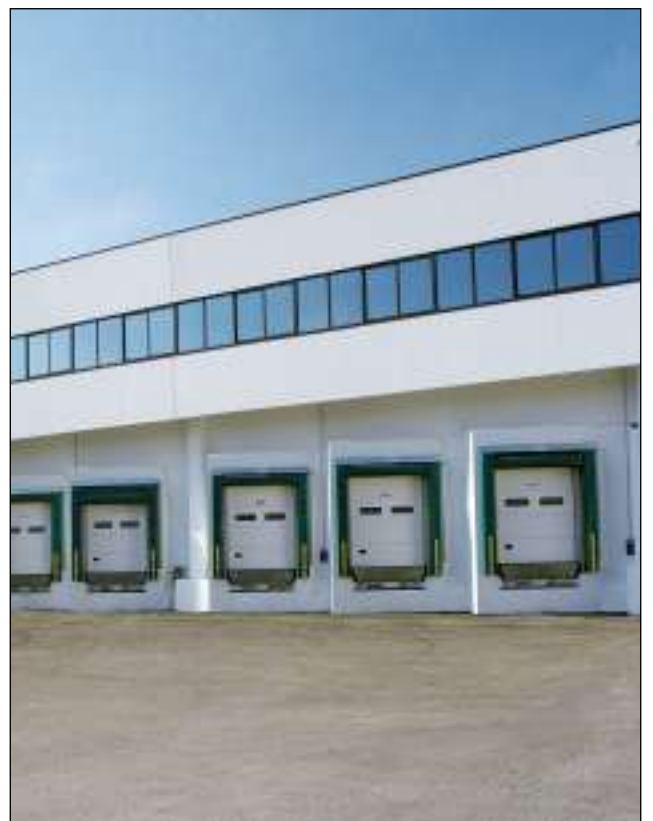
Punti di carico Loading docks Laderampen
