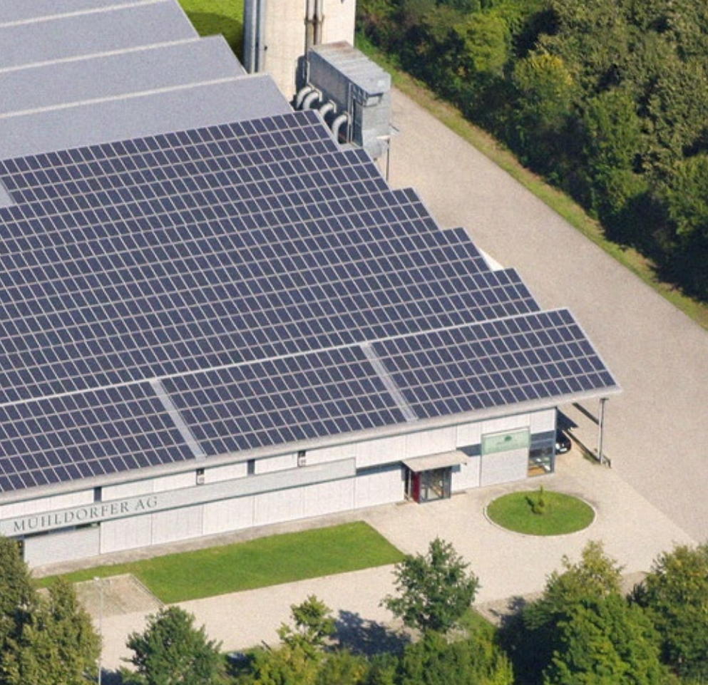
Firmenzentrale im oberbayerischen Mühldorf
