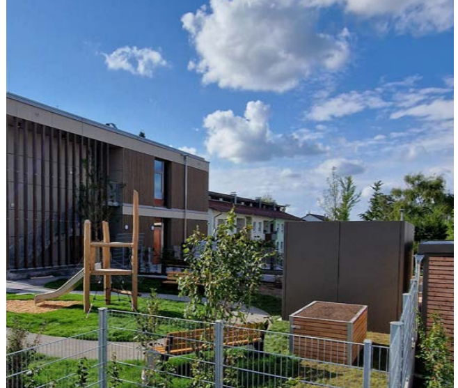
Schallschutzwand für Bauvorhaben Kita in Fellbach Wärmepumpe mit 70 kW und Schalleistungspegel 82 dB(A)
