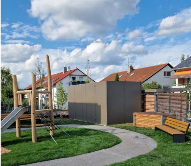
Schallschutzwand für Bauvorhaben Kita in Fellbach Wärmepumpe mit 70 kW und Schalleistungspegel 82 dB(A)
