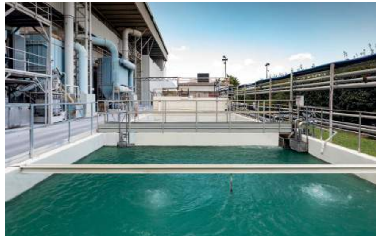
Aufbereitung des Wassers aus dem Produktionsprozess des Hauptsitzes (Fiorano Modenese - MO - Italien)
