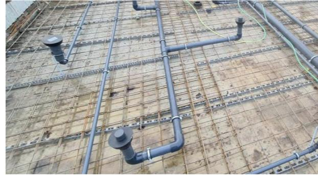
Sollte es bei den Betonarbeiten zu ungeplanten Höhendifferenzen kommen, können diese mit passenden Anschlussstücken ausgeglichen werden. Der Schalungsträger wird leihweise auf Pfandbasis gestellt und kann nach der Aufarbeitung wiederverwendet werden. Auf diese Weise fördern wir Nachhaltigkeit und entlasten die Umwelt.
