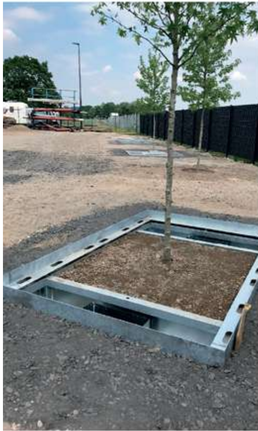
Abb. 2a: Ausführung der Baumrigole | Foto: Grüning, FH Münster
