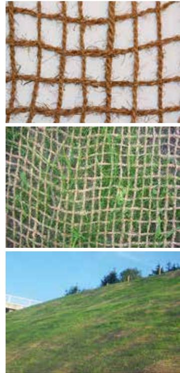
Böschungsbegrünung und Erosionsschutz mit Kokosgewebe; Neigungswinkel 20-35°
