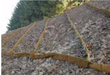
Rautenförmig oder parallel verlaufender Sicherungszaun, verfüllt mit Oberboden; Neigungswinkel 35-60°
