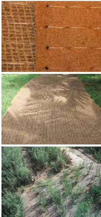
Gewebeverstärkte Spezialfasermatte schnelle und sichere Begrünung eines Lärmschutzwalls; bietet Rieselschutz
