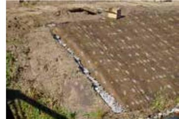
Böschungsbegrünung und Erosionsschutz in einem Muldengraben; Neigungswinkel 40-90°
