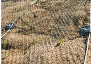
Böschungsbegrünung und Erosionsschutz mit zusätzlichem Steinschlagschutz; Neigungswinkel 30-80°
