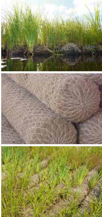
Ufersicherung mit Kokos-Geotextilwalzen GeoW mit Bepflanzung
