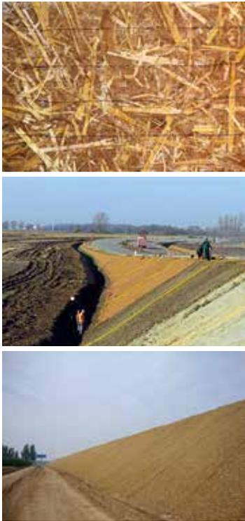
Begrünung und Erosionsschutz eines Entwässerungsgrabens; Neigungswinkel 0-25°
