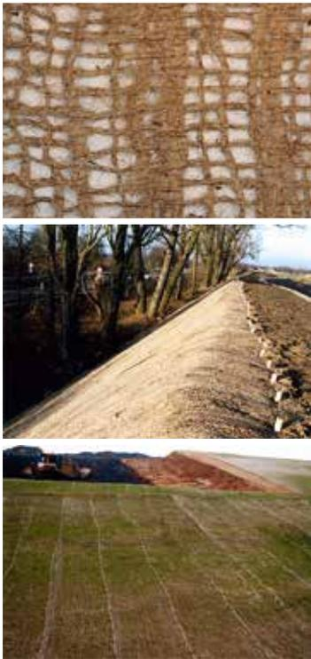
Böschungsbegrünung und leichter Erosionsschutz mit Jutegewebe; Neigungswinkel 0-25°
