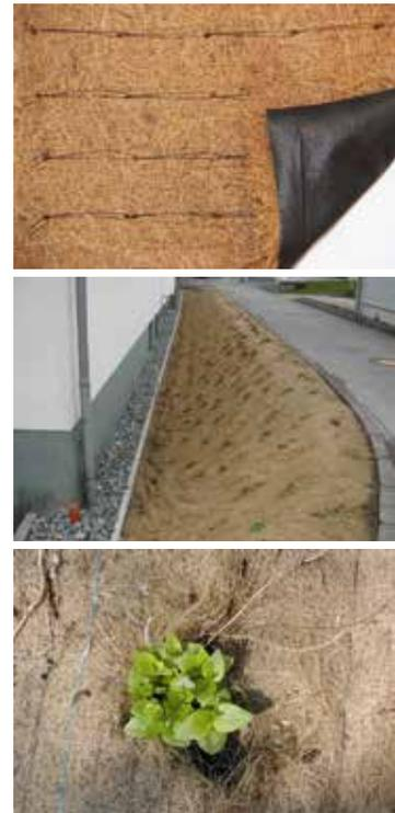
Begrünung eines Lärmschutzwalls mit verstärktem Rieselschutz
