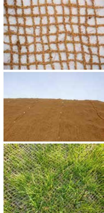
Begrünung und Erosionsschutz des Retentionsraumes (auslaufender Uferbereich)
