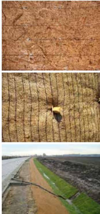
Böschungsbegrünung und Erosionsschutz mit einer Kokosfasermatte mit integriertem Saatgut; Neigungswinkel 10-30°
