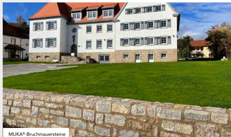
Bad Neustadt, MUKA®-Verblendmauerwerk
