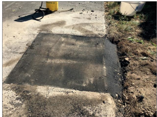
Bild 4: Instandgesetzte Fläche mit Pave Repair WMG 2
