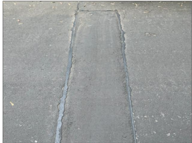
Bild 3: Sanierung mit Pave Repair HMG 5
