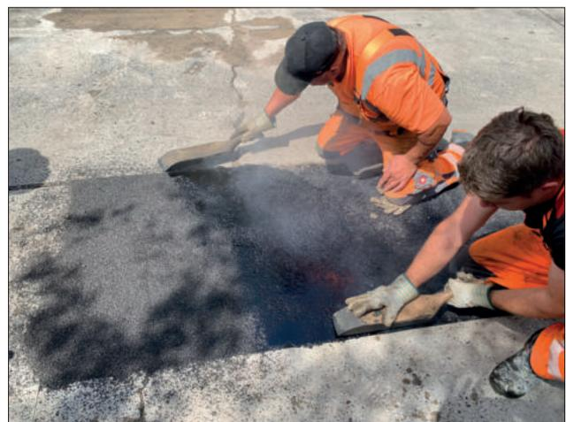
Bild 6: Einbau von Pave Repair HMG 8
