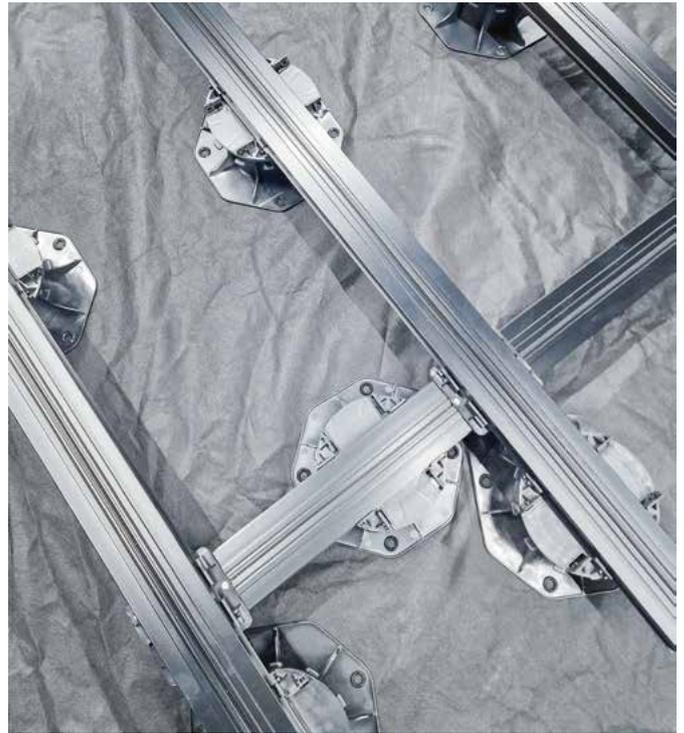
Konstruktion mit Verschraubung auf dem Boden
