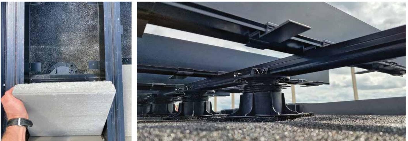
Beschwerung des Systems z. B. durch Beton- oder Stahl-Platten  $30 \times 30 \text{ cm}$  auf das geforderte Flächengewicht.
