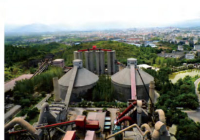
Anhui Conch Cement Co., Ltd.
