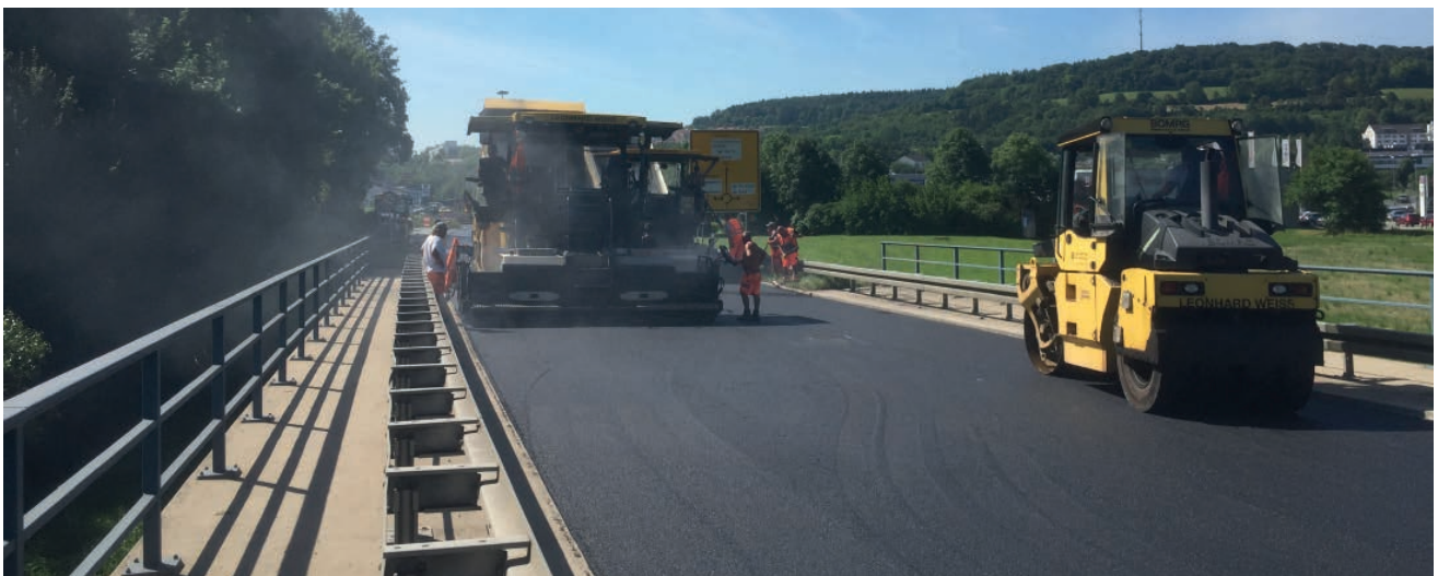
Projektfoto Einbau auf der B 290 bei Bad Mergentheim (2016)
