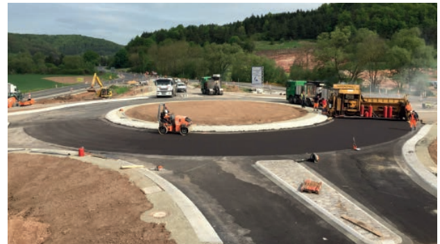
Abb. 2 Einbau von Gussasphalt im Kreisverkehr
