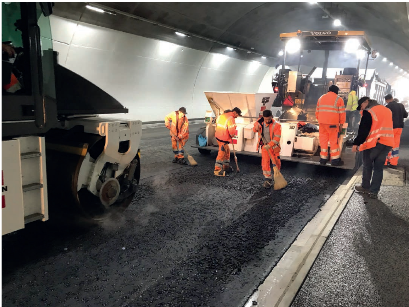
Tunnelbaustelle (Schweiz 2018) – Hot Rolled Asphalt mit Trinidad Naturasphalt
