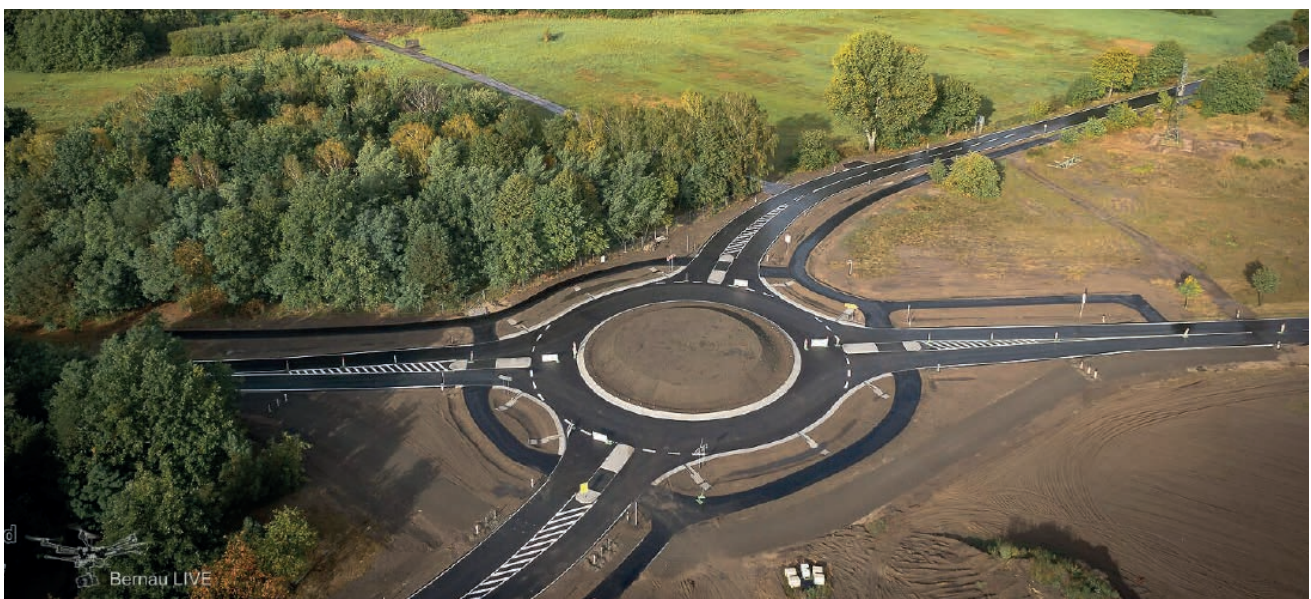
Abb. 3: Fertiggestellter Kreisverkehrsplatz mit Gussasphaltdeckschicht (B 287 Wandlitz/Brandenburg)
