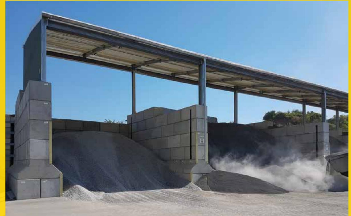
Boxenüberdachung mit Befüllungs- und Entnahmestationen
