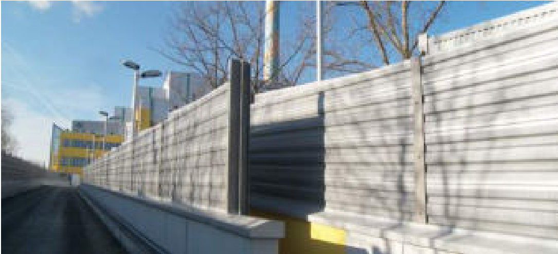
D-Frankfurt-Heddernheim, Müllkraftwerk, KOHLHAUER ALUMNA®
