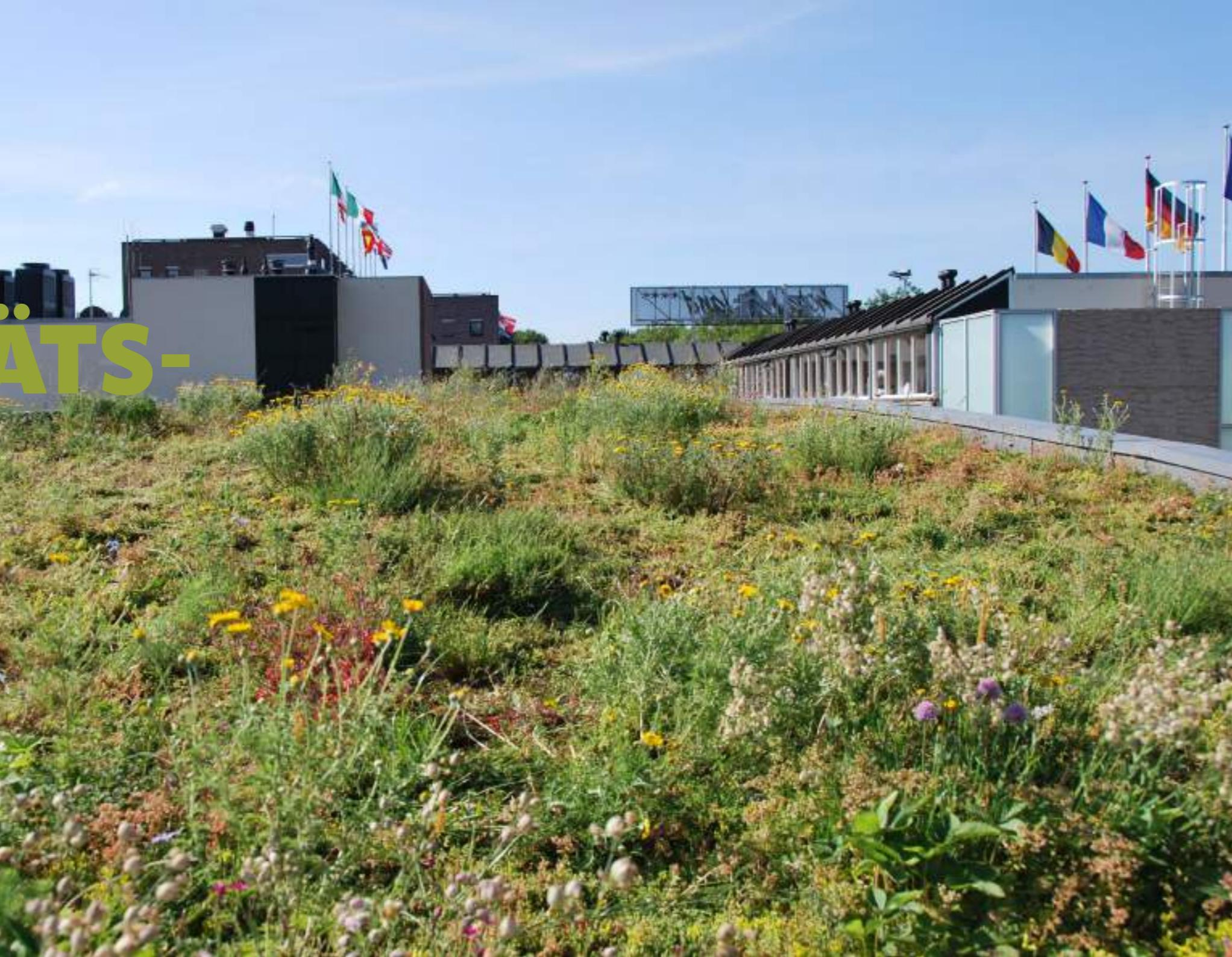
Sempergreen bietet mehrere Arten von Biodiversitätsdächer für flache und leicht geneigte Dächer an. Das Biodiversitätsdach Leicht mit Biodiversitätsmatte Sedum-Kräuter kann beispielsweise ein Dach mit geringerer Tragfähigkeit in ein farbenfrohes Dach verwandeln.
