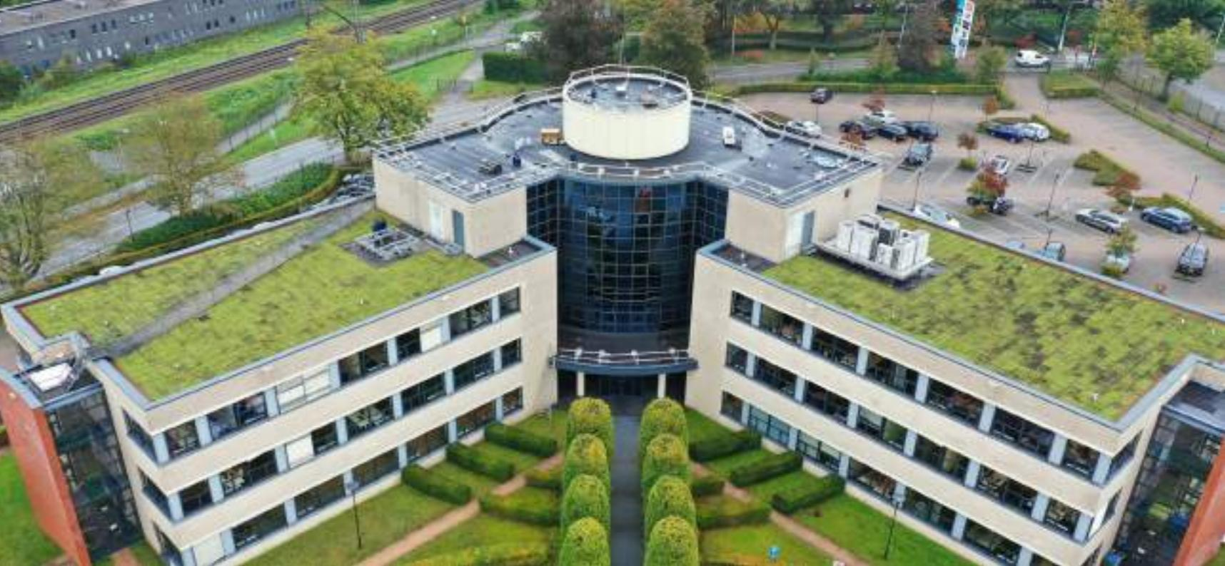
Mit diesen Systemen kann der Regen dort aufgefangen werden, wo er zuerst fällt: auf dem Dach! Das Detentionsdach ist relativ leicht und eignet sich für geneigte Dächer bis 2 Grad Dachneigung und kann bei Sanierungsprojekten eingesetzt werden. Ein Retentionsdach ist eine vielseitige Lösung für Neubauprojekte und kann z. B. mit Sonnenkollektoren und einer biodiversen Bepflanzung kombiniert werden.
