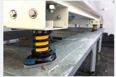
Rückkühler auf Dach installiert
