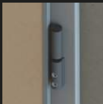
CERNIERA AVVITATA REGOLABILE ADJUSTABLE SCREWED HINGE
