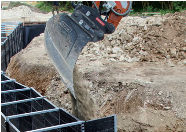
7. Verfüllen mit Aushub
