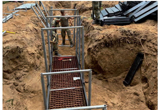
4. Stabilisierung durch erste Wandprofile und Bodengitter
