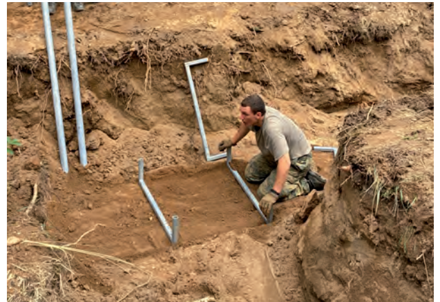
2. Nivellieren der Sohle
