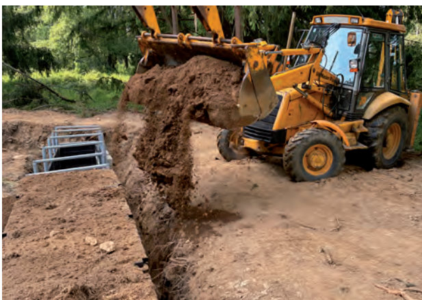
11. Abdeckungen mit Aushub bedecken
