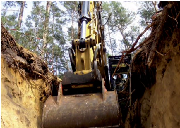
1. Ausheben des Grabens
