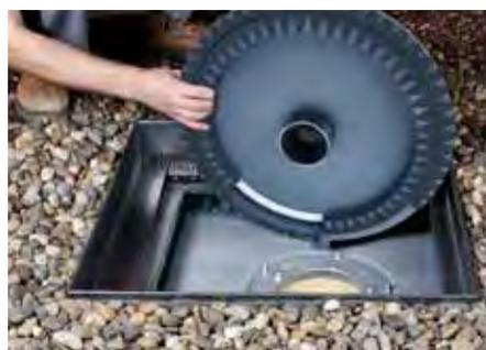
Das Retentionsdrossel-Set RDS 48 wird eingesetzt beim Einbau über Flachdachabläufen mit Schraubflansch.
