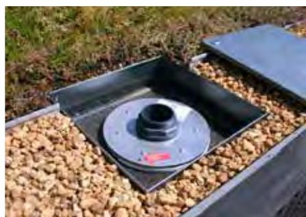
Das Drosselement liegt geschützt unterhalb des Kontrollschachts und reguliert den langsamen Wasserabfluss. Es fungiert gleichzeitig als Überlauf.
