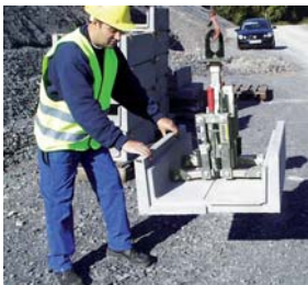
Kabelkanal-Versetzzange KKV-200
