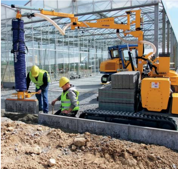
TRANSMOBIL TM Verlegetransporter bei der Bordsteinverlegung
