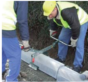
Bordsteinversetzzange BVZ
