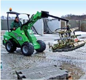
Hydraulische Verlegezange am Minilader
