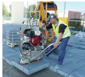
POWERJET PJ-1650-B Vakuum-Anbaugerät
