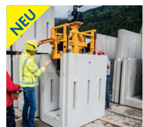
Mechanischer Greifer zum Versetzen von Grabenmauern- Elementen
