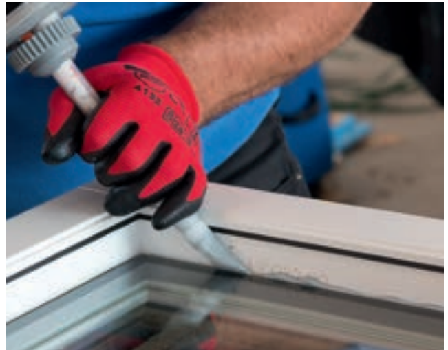
Manuelle Verarbeitung von OTTOCOLL® S81 mit der BlueLine Kartusche
