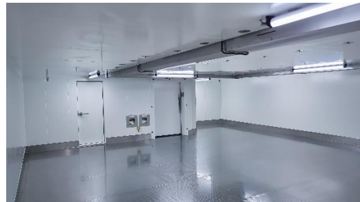
Abbildung 2 Lagerraum der ULT-Anlage
