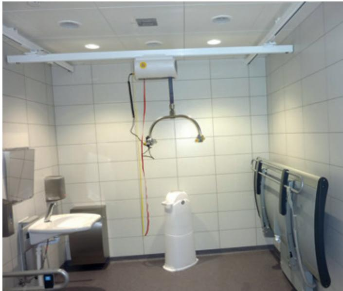
Mit Traversenschiene in einer „Toilette für alle“ jeden Bereich erreichen
