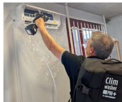
Leistungstarker Wasserstrahl mit 8–15 bar, ideal für Außengeräte
