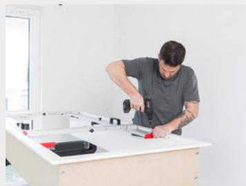
4. Zargenblitz an den Bohrbuchsen mit der Zarge verschrauben
