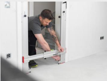
7. Türzarge mit den verstellbaren Füßen und Wasserwaage ausrichten
