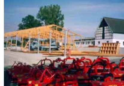
Bau der 2.500 m 2 großen Ausstellungshalle in Felbecke
