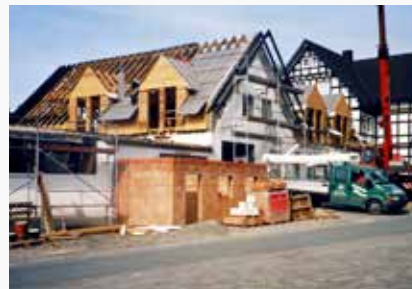
Ausbau und Erweiterung des Bürogebäudes
