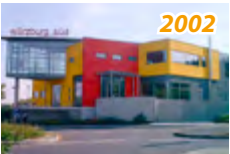
2002 AUTOBAHNRASTSTÄTTE WÜRZBURG SÜD • BHKW EWM 70 S Erdgas • Absorber WEGRACAL SE 80
