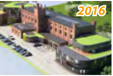
2016 TCS GENTHIN • BHKW EWM 70 S Erdgas • Absorber WEGRACAL SE 80
