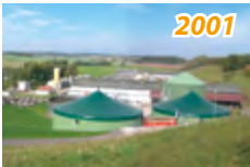
2001 LANDWIRTSCHAFTLICHES UNTERNEHMEN RIETH • BHKW EWM 366 TL • Absorber WEGRACAL SE 50
