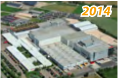
2014 HAMA MONHEIM • BHKW EWM 140 S Erdgas • Absorber WEGRACAL SE 150
