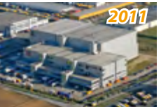
2011 GEBRÜDER HEINEMANN HAMBURG • BHKW 3 x EWM 50 S Erdgas • Absorber WEGRACAL SE 50
