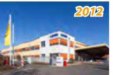
2012 LEONI KITZINGEN • BHKW EWM 70 S Erdgas • Absorber WEGRACAL SE 80
