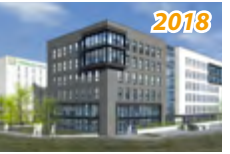
2018 RAIBA-CENTER SCHWABACH • BHKW EWM 20 S • Absorber WEGRACAL Maral 2
