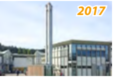
2017 LEAR KRONACH • BHKW EWM 140 S • Absorber WEGRACAL SE 150
