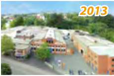
2013 DESCH ARNSBERG • BHKW 2 x EWM 140 S Erdgas • Absorber 2 x WEGRACAL SE 150
